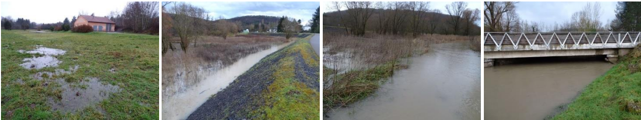
Nappe alluviale Weihergraben - digue et débordement de la Rosselle le 3 février 2021 – Rosselle à Rosbruck
